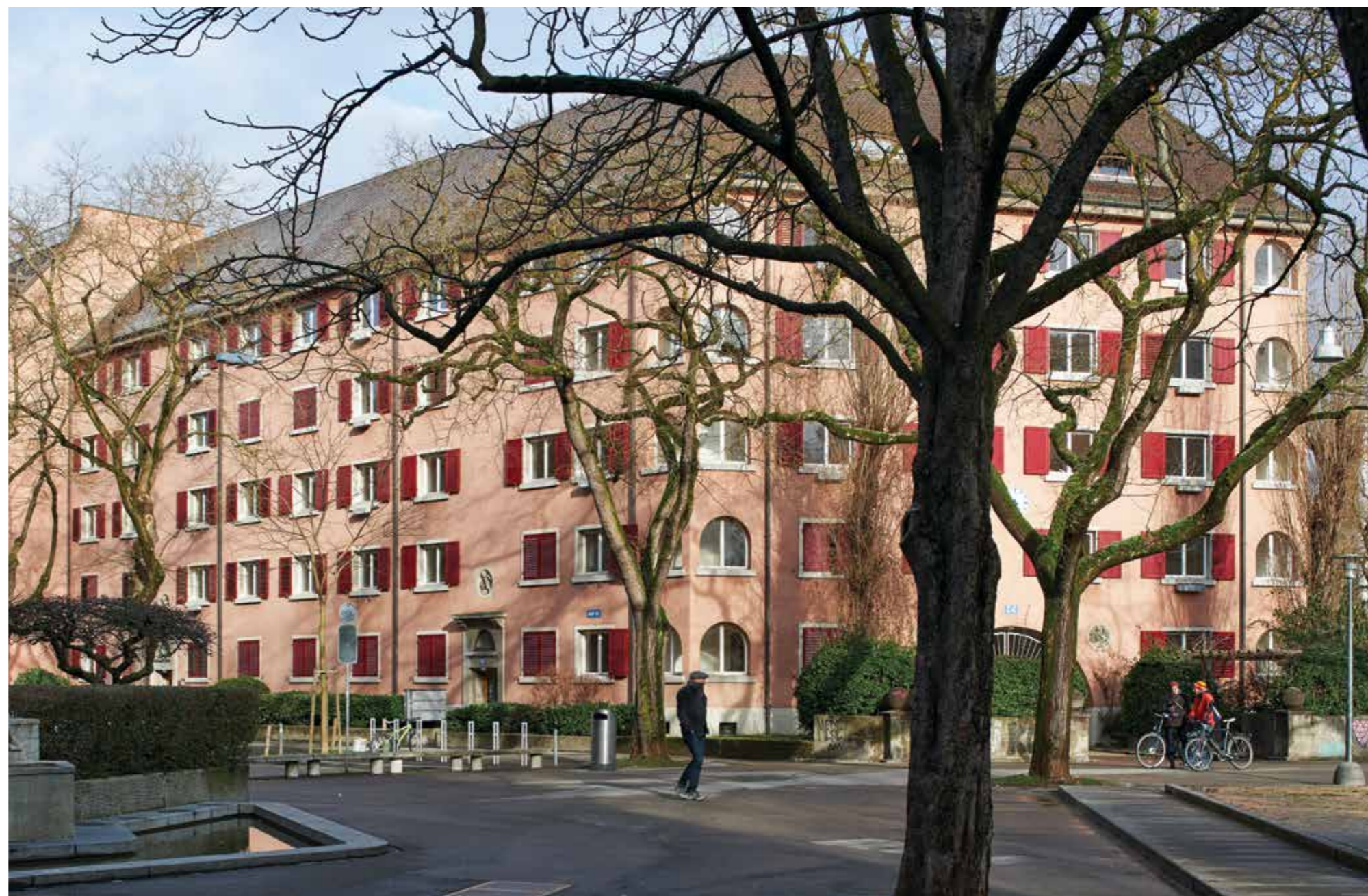
Siedlung Industrie 2 beim Röntgenplatz mit 80 Wohnungen für ca. 180 Mieterinnen und Mieter
